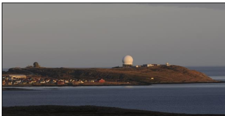
Рисунок 2. Радиолокационная станция «Глобус-2» системы ККП США в н.п. Вардё
