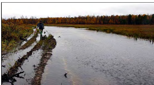
Рис. 16. Заболачивание на участках разъездов, Надымский ЛУ (фото автора)
