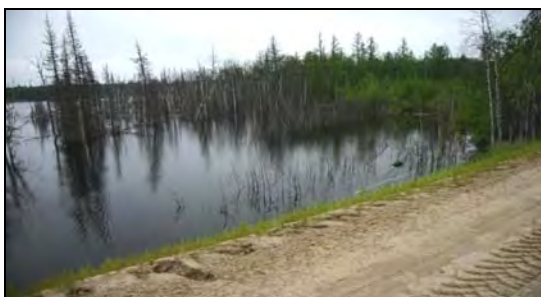
Рис. 15. Нарушение стока в результате строительства дороги, Береговой ЛУ (фото автора)
